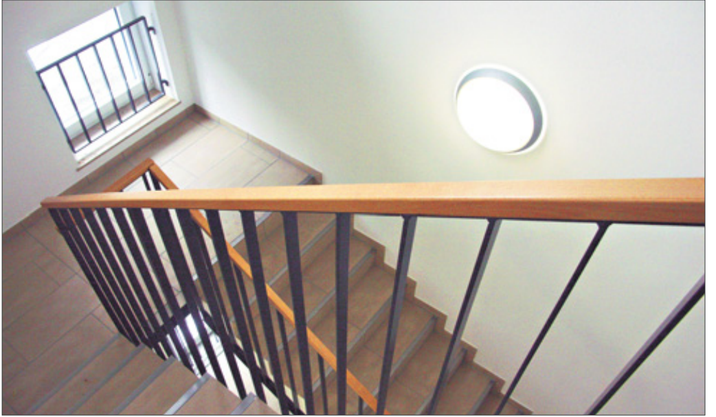
Eine besondere Herausforderung für die Firma Berge Bau war das Treppenhaus der neuen Berleburger Polizeiwache – doch auch das erscheint jetzt in neuem Glanz.
