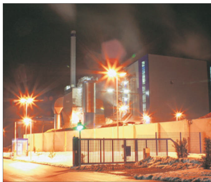
Die starke Beleuchtung des Biomasse-Heizkraftwerks im Industriepark Wittgenstein stört viele Anwohner und viele Wittgensteiner allgemein. Das wurde bei einer Informationsveranstaltung am Donnerstagabend in Schameder deutlich.
