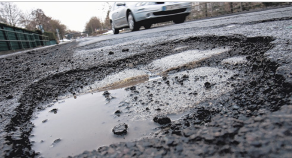
Bilder wie dieses sollen bald in den Kreisen Altenkirchen und Neuwied weniger zu finden sein: schon in Kürze werden Reparaturarbeiten an den Winterschäden beginnen. Foto: ddp
