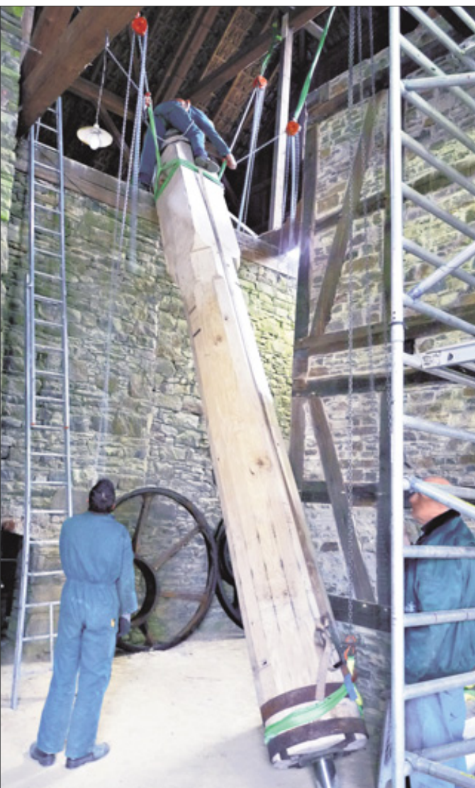
Es war ein Kraftakt, die etwa zwei Tonnen schwere Gebläsewelle über die Mauer in der Gießhalle des Museums Wendener Hütte zu hieven. Foto: mari
