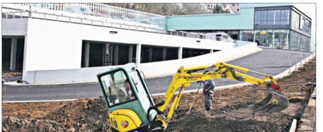
Alle Bauarbeiten pünktlich zu beenden, stellte die Beteiligten vor Herausforderungen, denn erst im vergangenen August wurde hier der Grundstein gelegt. Foto: kaio
