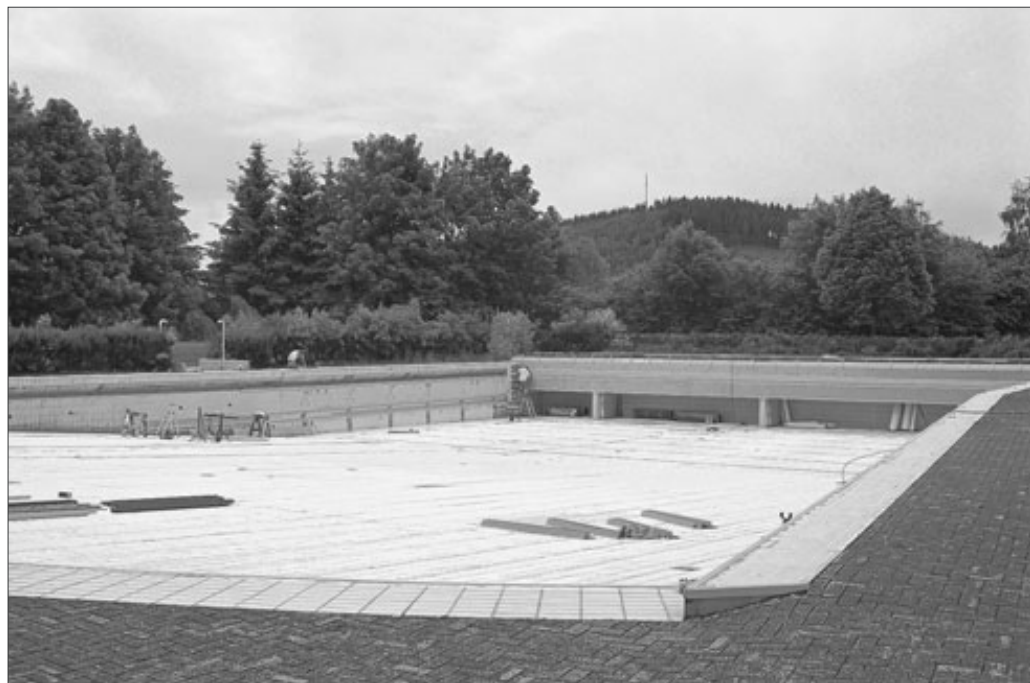
Aktuell laufen noch die Kernsanierungsarbeiten im Bad Berleburger Freibad am Stöppel. Ende Juni soll die Freibad-Saison starten, auch neue Pächter für die Gastronomie wurden mittlerweile gefunden.
