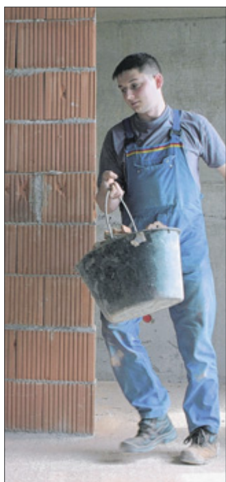
Auch im Innenbereich hat der Bauherr viel Arbeit vor sich.
