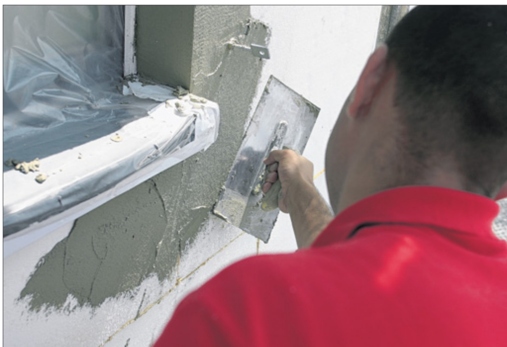
Wenn die Wände erstmal stehen, geht der Hausbau in die nächste Runde. Auch das Verputzen gehört dann zu den Aufgaben. Fotos: ddp
