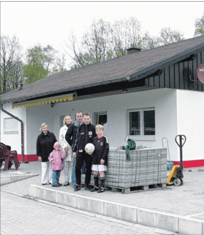
Das schicke Sportheim des REWE-Sportparks Obersdorf-Rödgen wurde neu gestrichen und strahlt nun in neuem Glanz. Fotos: cg
