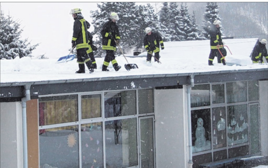
Die Kameraden der Freiwilligen Feuerwehr räumten am Montag mit rund 80 Einsatzkräften die Dächer der Kindergärten in der Gemeinde Burbach.
